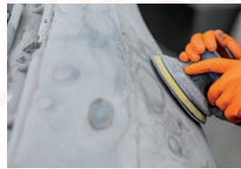
Bakım ve Onarım
